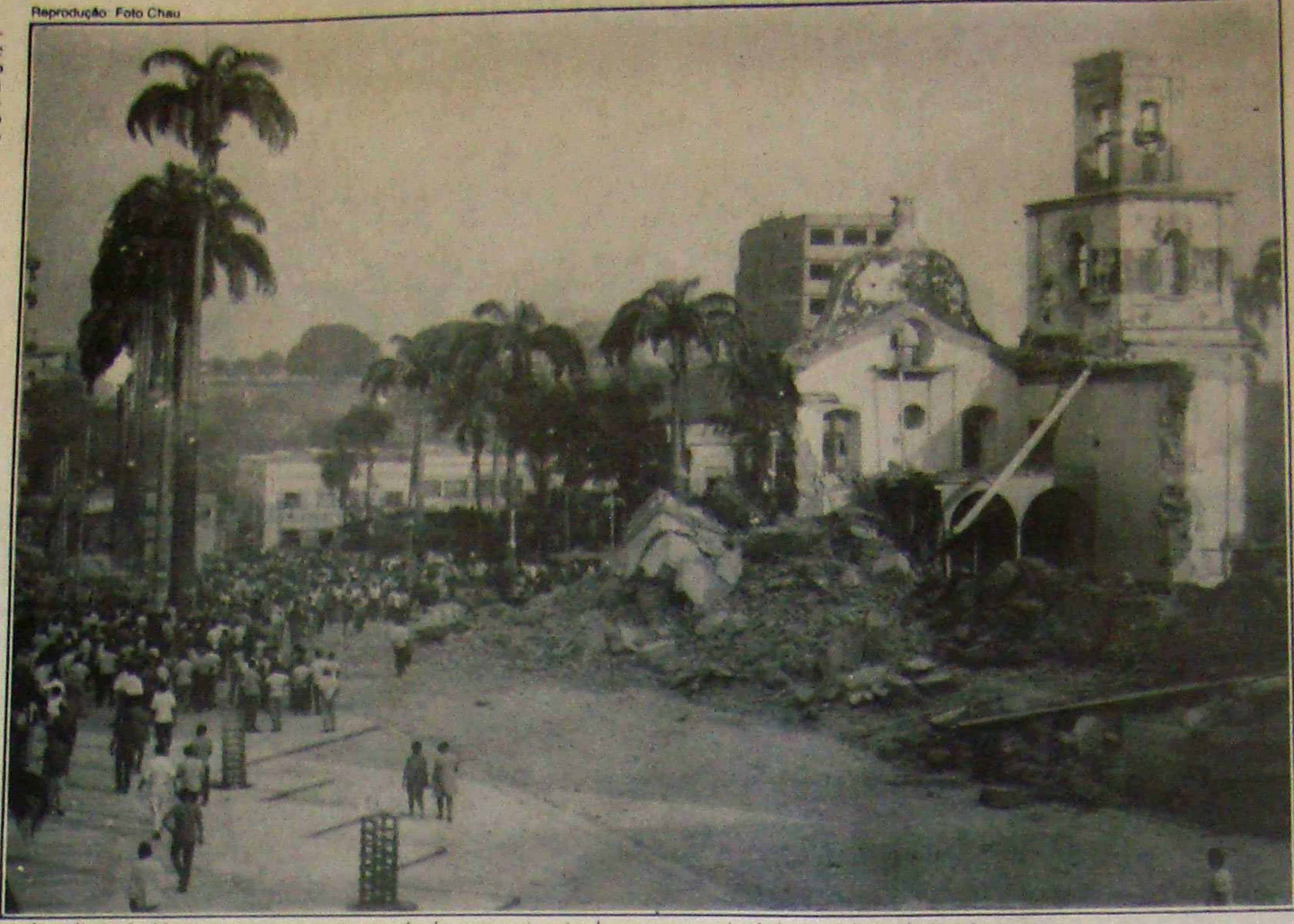
A demolição da Matriz: momento marcante da descaracterização dos traços arquitetônicos originais de Cuiabá
